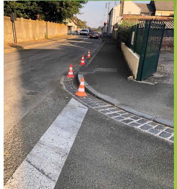
Rénovation des joints pavé caniveau (Rompox)
